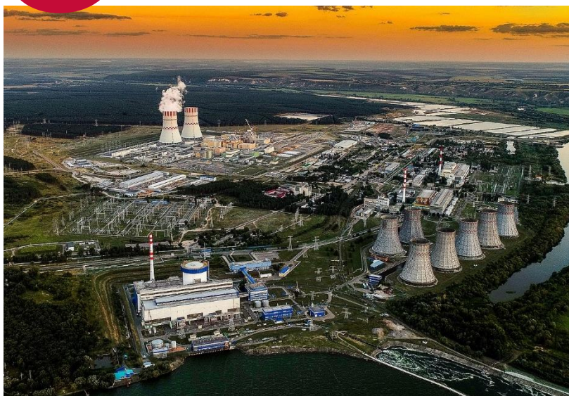
Строительство и запуск Нововоронежской АЭС
