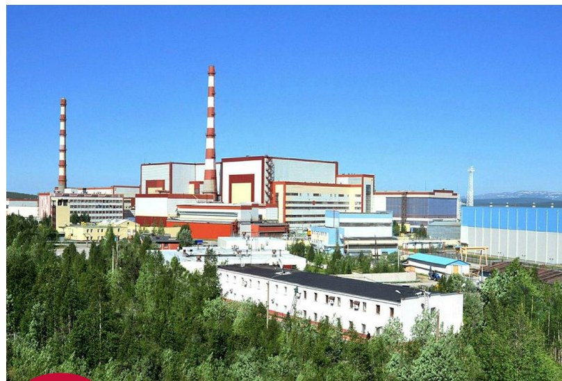
Строительство Кольской АЭС
