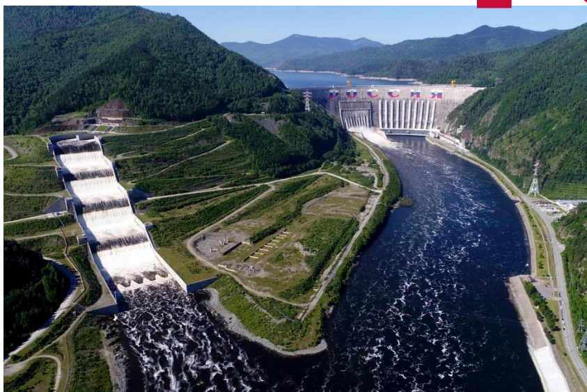
Строительство Саяно- Шушенской ГЭС Имени Петра Степановича Непорожнего N уст = 6400 МВт
