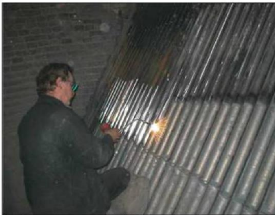
Рис. 1. Читинская ТЭЦ-2. Наплавка износостойкого материала на трубы заднего экрана на высоту 1,5 м над слоем.
